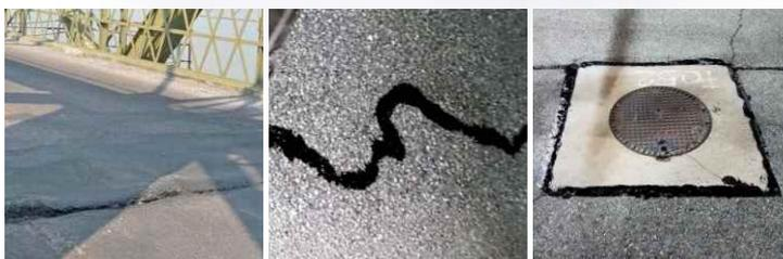
**SigilRapid Plus** è un sigillante polimerico monocomponente a freddo, elastico, ideale per la sigillatura di lesioni su pavimentazioni bituminose e in cls. Appositamente realizzato per essere colato manualmente con rapida reticolazione superficiale. Certificato per pavimentazioni aeroportuali.
