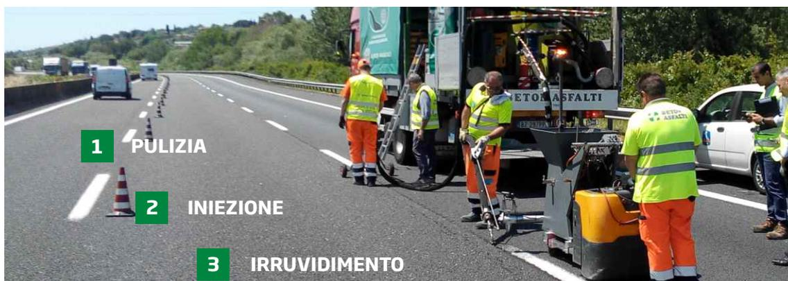
**SBS Sigil PLUS** è una tecnologia che si avvale per la sua realizzazione di un **impianto mobile, unico nel suo genere**, completo di tutte le attrezzature professionali per l'esecuzione di sigillature a caldo, di lesioni longitudinali e trasversali del piano stradale, garantendo un'alta produttività, una rapida esecuzione dei cantieri, facili spostamenti e completa autonomia.
