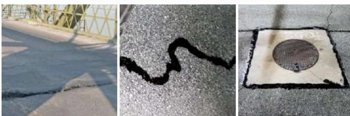
**SigilRapid Plus** ist ein monokomponentes kaltes und elastisches Versiegelungsmittel, ideal zum Abdichten von bituminösen Bodenbelägen und CIS. Eignet sich besonders für die manuelle Auffüllung der Fugen mit rascher Oberflächenvernetzung. Zertifiziert für Flughafenbodenbeläge.
