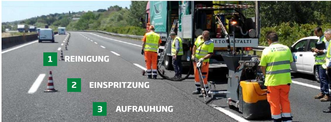
**SBS Sigil PLUS** ist eine Technologie, für deren Einsatz eine **in ihrer Art einzigartige mobile Anlage** verwendet wird, die mit allen professionellen Ausrüstungen für die Heißversiegelung von Quer- und Längsrissen im Straßenbelag ausgestattet ist, und somit hohe Produktivität, rasche Ausführung der Baustellen, einfachen Transport sowie große Mobilität gewährleistet. Mit dieser mobilen Anlage arbeiten wir **in ganz Italien, einschließlich der Inseln**. Diese Dienstleistung beinhaltet:
